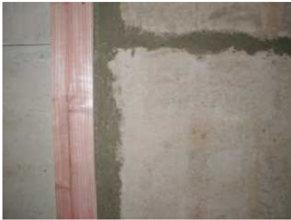
柱際などの隙間を中塗り材料で充填
