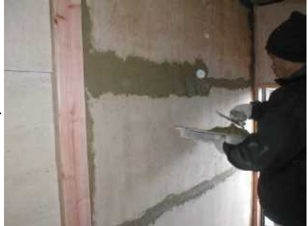
ジョイント部分をシゴキ塗り
