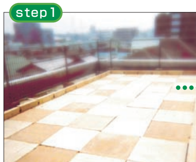
屋上に緑化パネルを敷き詰めます。
