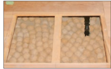
住宅床下での施工例
